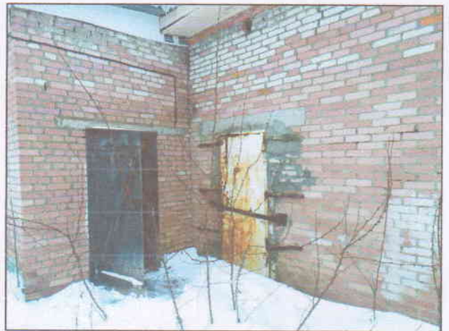
22.12.2022 А1/к-здание магазина №10, 1-пристройка(котельная)
